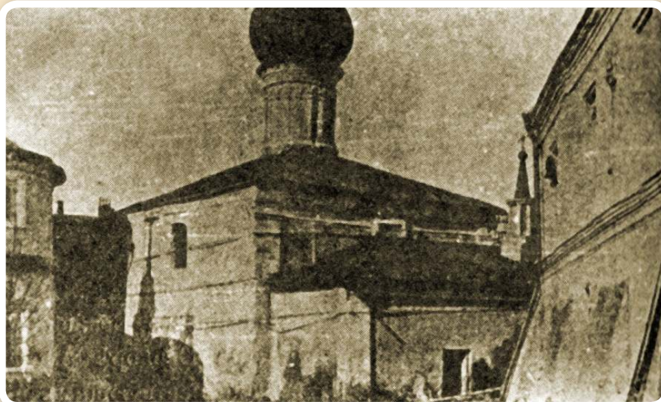
Храм Прп. Марии Египетской, разрушенный большевиками
